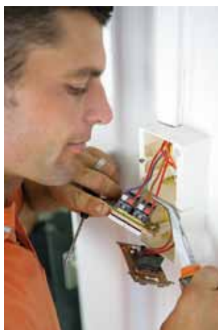
Raccordement d'un appareillage hors tension.
