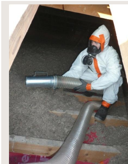
Fig. 5 Soufflage de laine de roche en espace confiné
