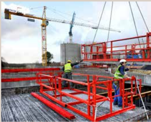
Fig. 9 Cadre de sécurité monobloc extensible
