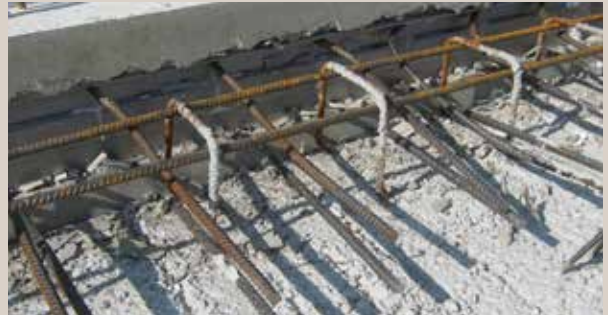
Fig. 16 Dépliage des armatures de liaison
