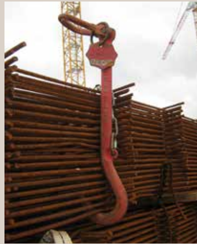
Fig. 15 Nœud de ferrailage prédalle suspendue
