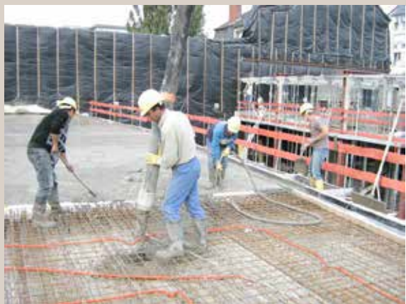
Bétonnage à la pompe
